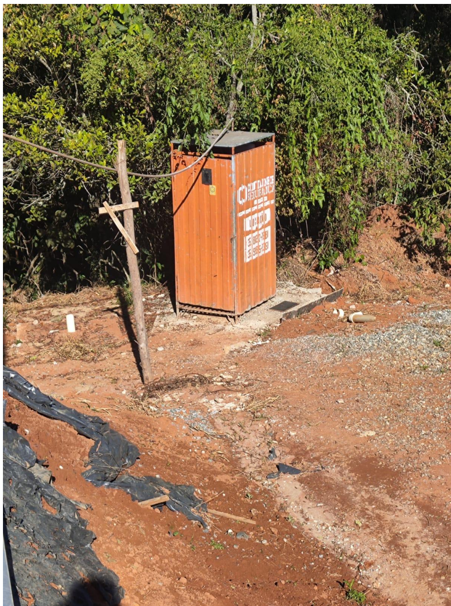
Imagem do container que é o banheiro
