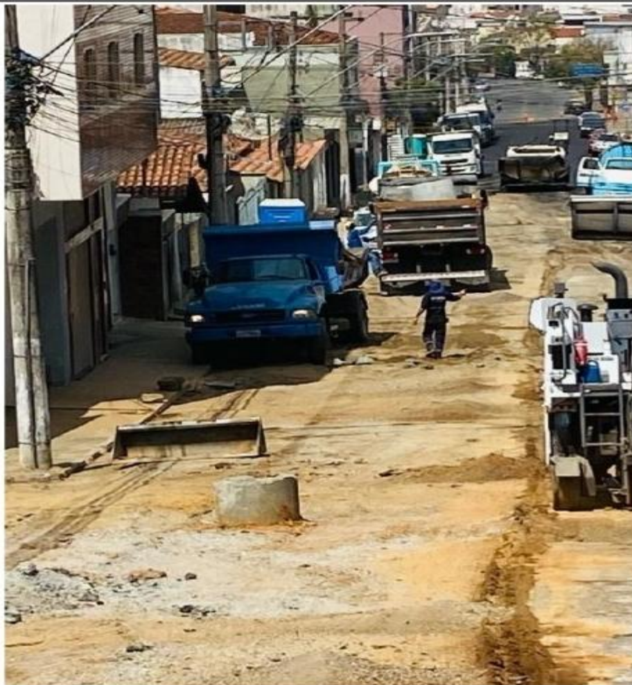
Empréstimo de solo para reaterro
