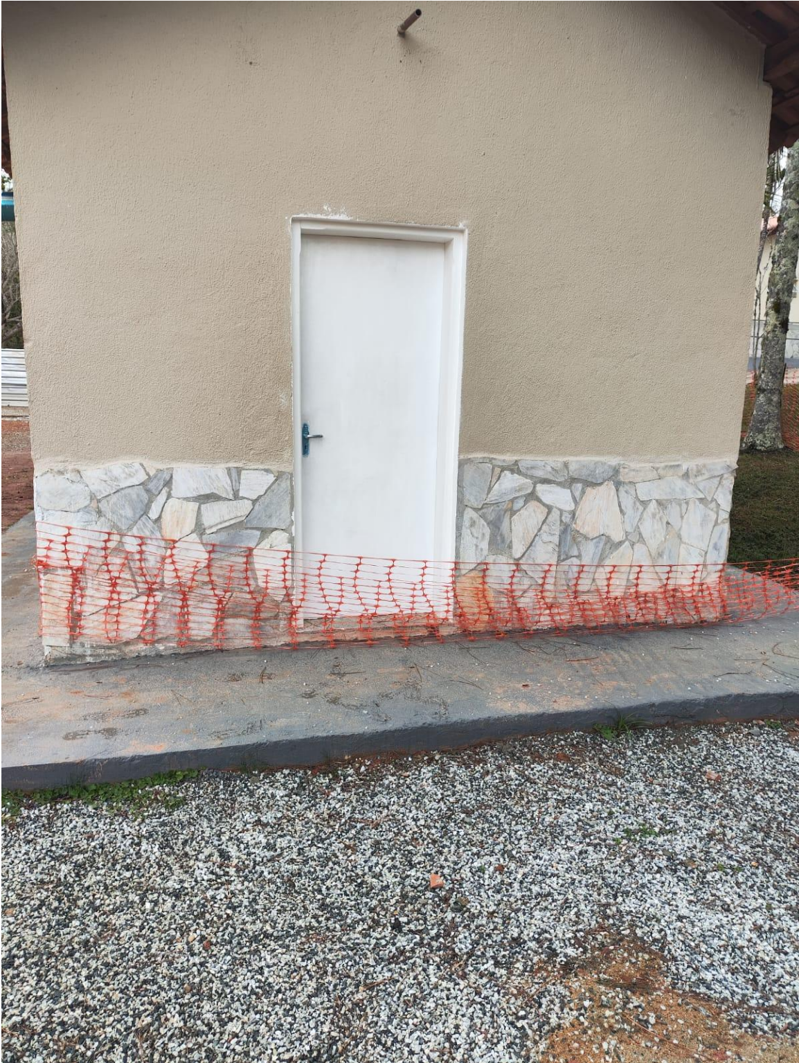
Porta já se encontra levemente empenada devido a humidade do local e a qualidade da porta.
