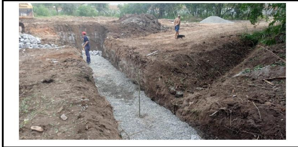
PREPARO DE FUNDO DE VALA
