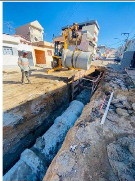
Execução de tubulação manilha 800
