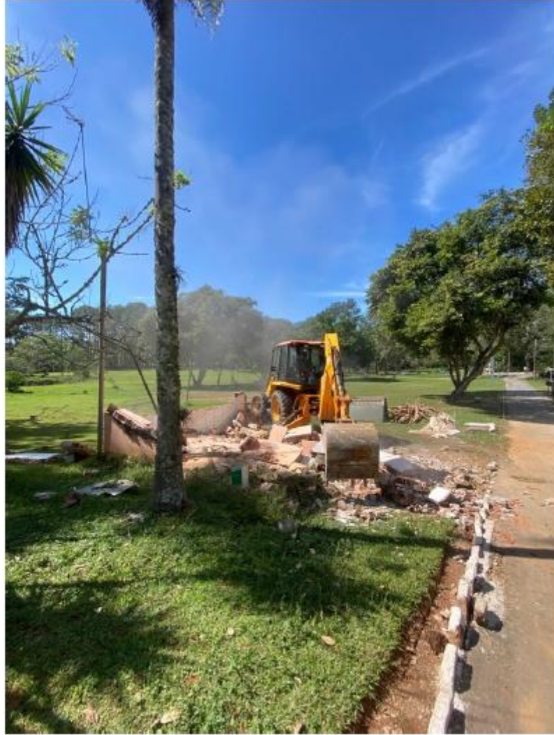
Demolição da cantina.
