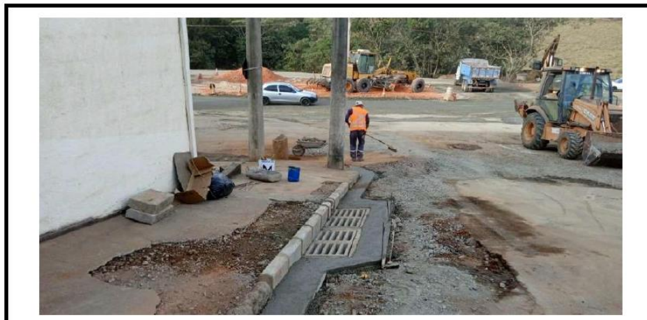
CONSTRUÇÃO DE BOCA DE LOBO
