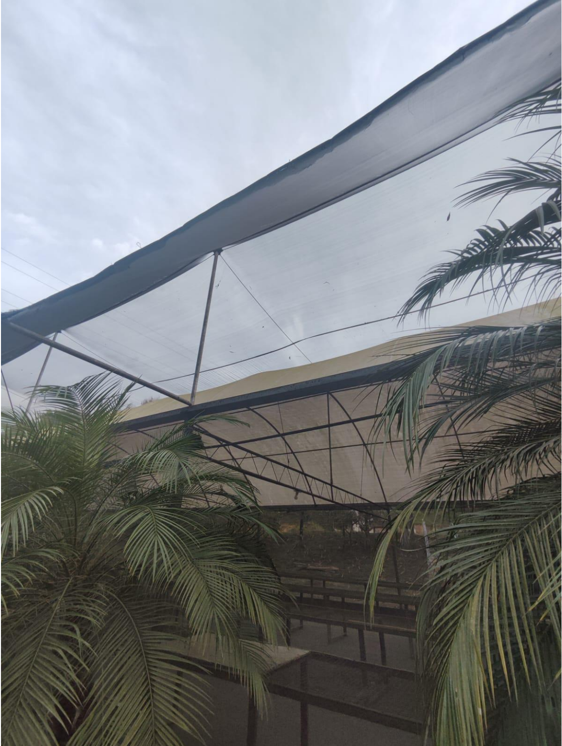
Registro do vão entre a estufa e a cobertura do talude.
