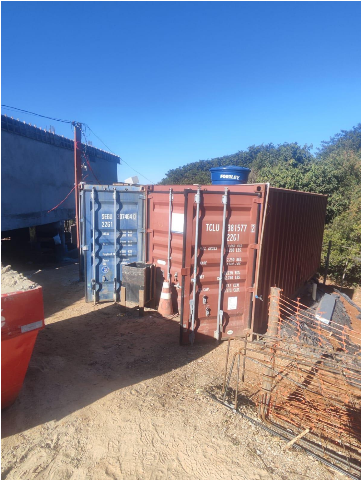
Imagem dos demais container que estão na obra
