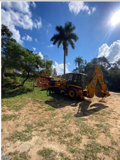
Execução de escada em talude para acesso.
