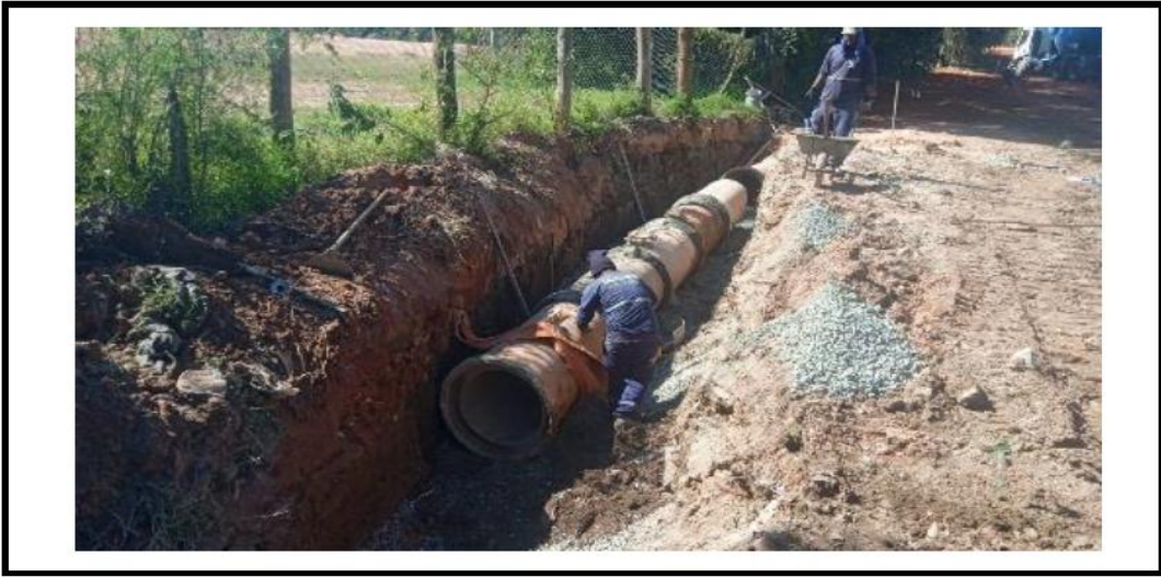
ASSENTAMENTO DE TUBOS DE CONCRETO
