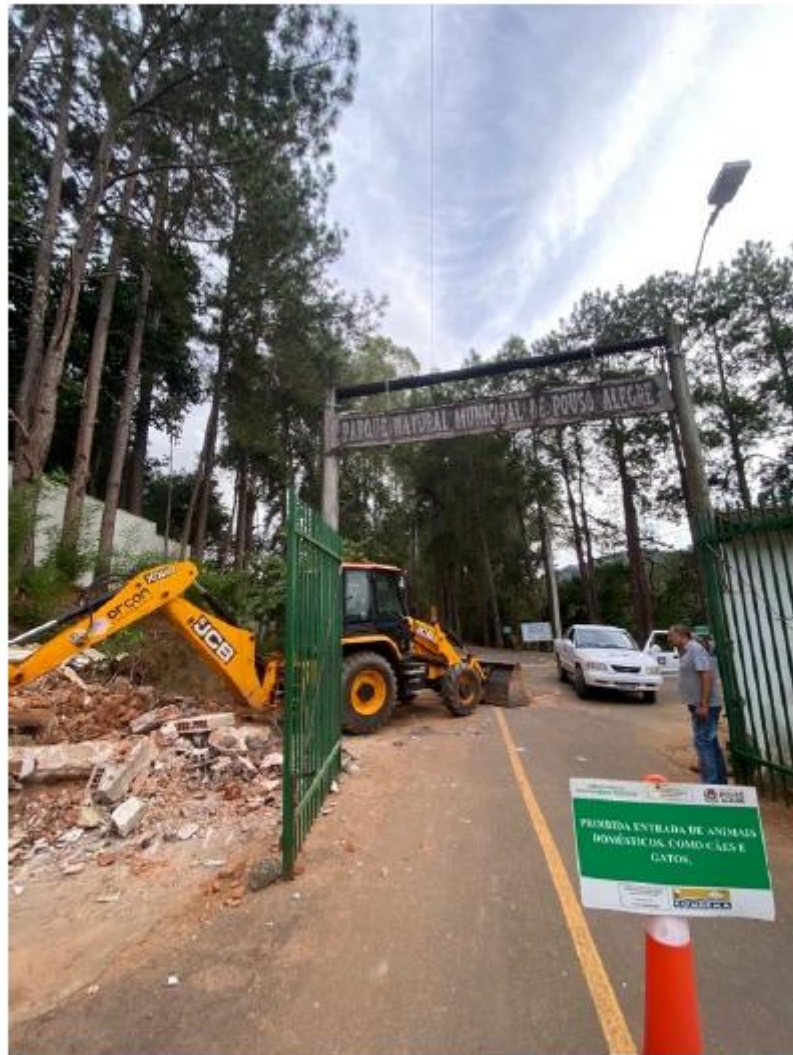
Demolição de guarita.
