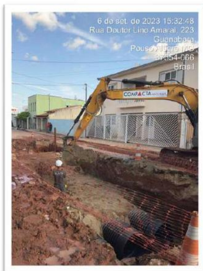
DESCRIÇÃO DO SERVIÇO: EXECUÇÃO DA DO PREENCHIMENTO COM AREIA.
