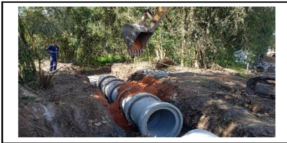
ASSENTAMENTO DE TUBOS DE CONCRETO
