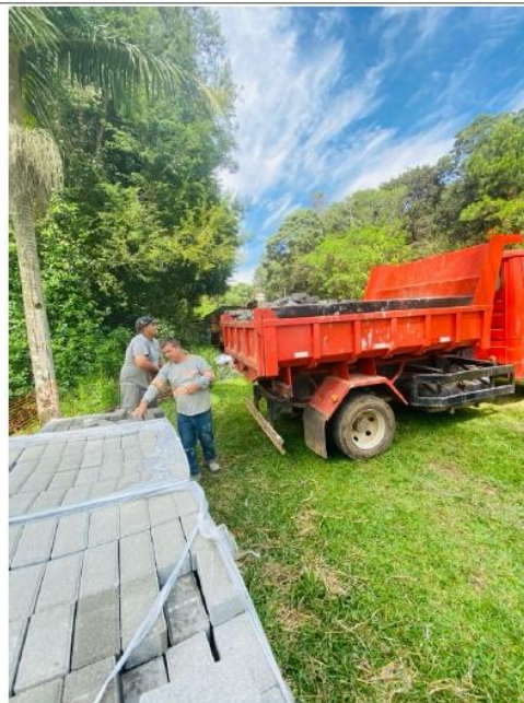
Execução de piso intertravado praça de atividades.
