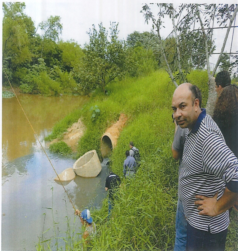
Figura – Lançamento de esgoto no Rio Sapucaí proveniente da E.T.E. Cidade Jardim (ponto 25 no mapa)
