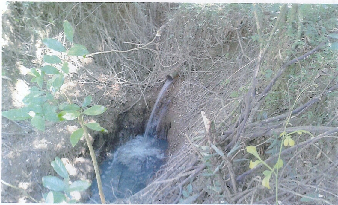
Figura – Lançamento esgoto bairro Faisqueira
