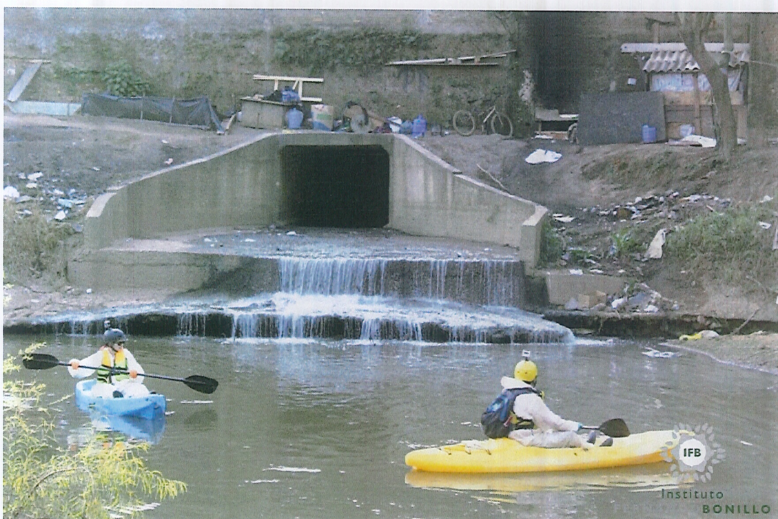
Figura – Contribuição indevida na rede de drenagem, próximo à perimetral e o Supermercado Bretas (ponto 7 no mapa)
